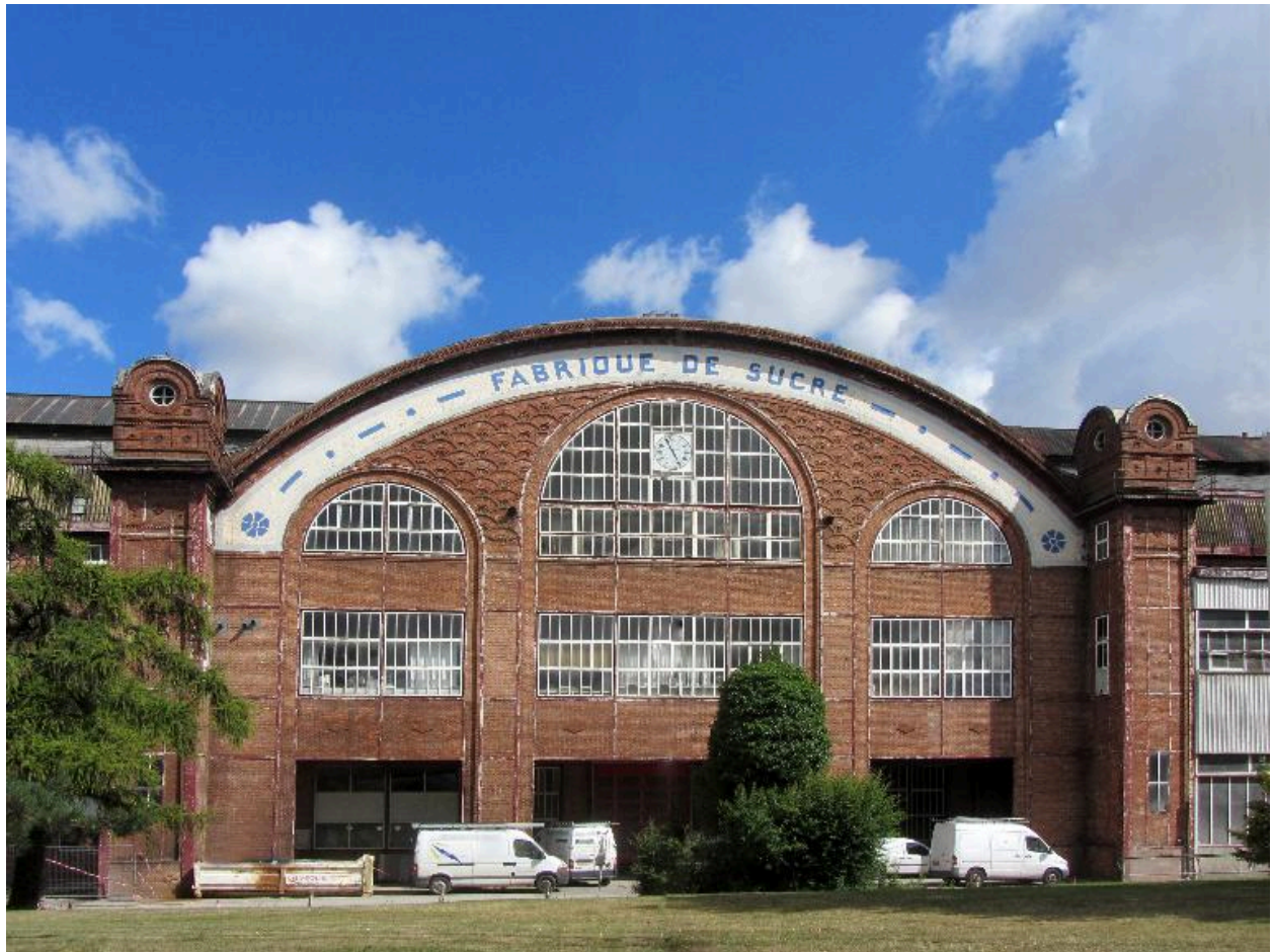
Façade de l'atelier principal de la sucrerie.
